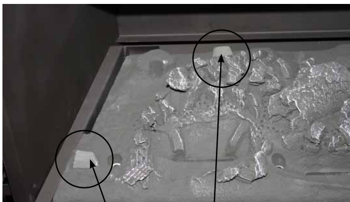
Emplacement des tiges de la bûche A sur le plateau du brûleur
